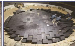
40500KVA电石炉炉底碳砖砌筑施工
